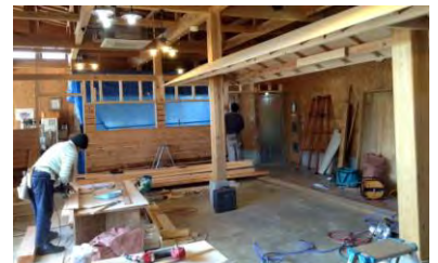
↓ あちこちに壁を作ったり大がかりな工事でしたが、2日で完成！
